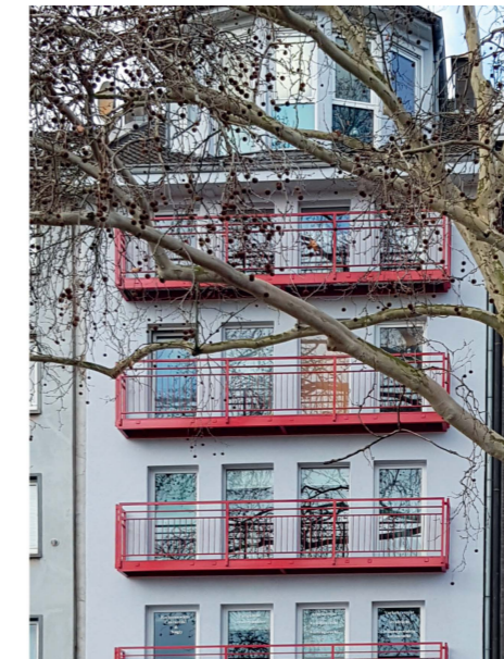
2. PLATZ «Häuser ohne Stuck»: Mercatorstr. 92, DU-Dellviertel
