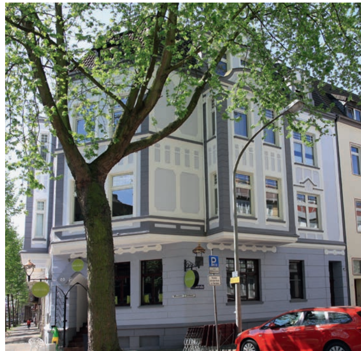
1. PLATZ «Häuser mit Stuck»: Fuldastr. 20, DU-Altstadt
