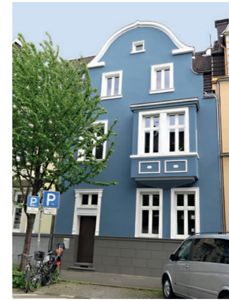
1. PLATZ «Häuser ohne Stuck»: Neckarstraße 54, DU-Mitte
